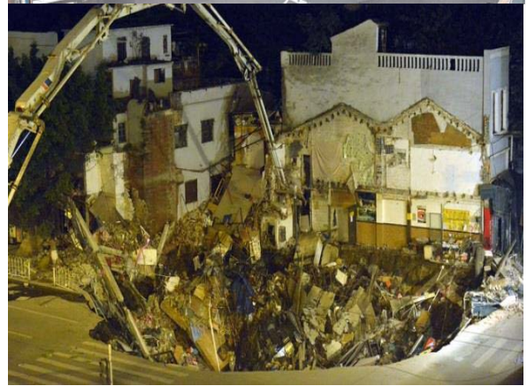
شکل (۱). نشست‌های ناشی از حفاری‌های زیر زمینی الف) فرو نشست فوکوکا ژاپن، ب) فرو نشست در شهر گوانجو چین
