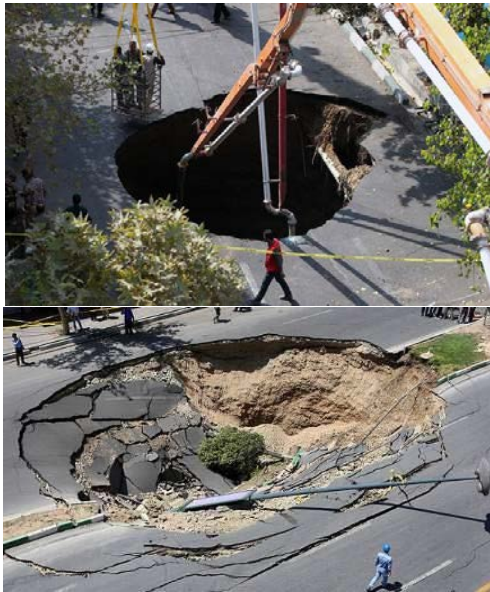
شکل (۲). فروچاله‌های ایجاد شده در شهر تهران ناشی از حفر فضای زیر زمینی
