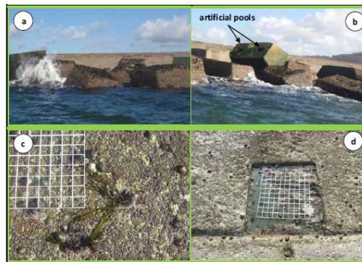
شکل (۱۲). ایجاد فضاهای متخلخل روی سطوح بتنی
