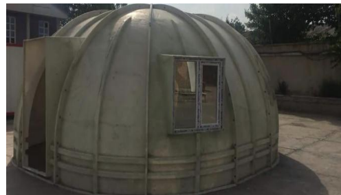
شکل (۱): نمونه پناهگاه گنبدی قبل از بتن‌ریزی.
