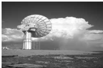
شکل ۷- رادار VHF توان بالا با دهانه آنتن ۱۵۰ فوت جهت تشخیص اهداف با سطح مقطع راداری بسیار کم
