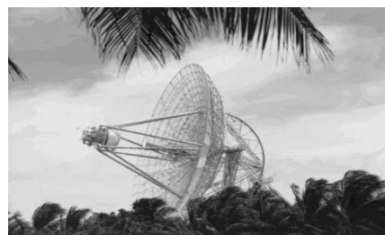
شکل ۷- رادار VHF توان بالا با دهانه آنتن ۱۵۰ فوت جهت تشخیص اهداف با سطح مقطع راداری بسیار کم
