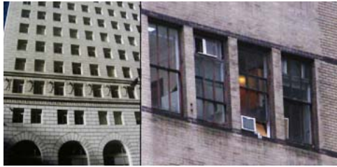
شکل ۱۵- پنجره‌های حفره‌ای (سمت چپ) و پنجره‌های نواری (سمت راست) (Homeland Security & FEMA, 2011: 239)
