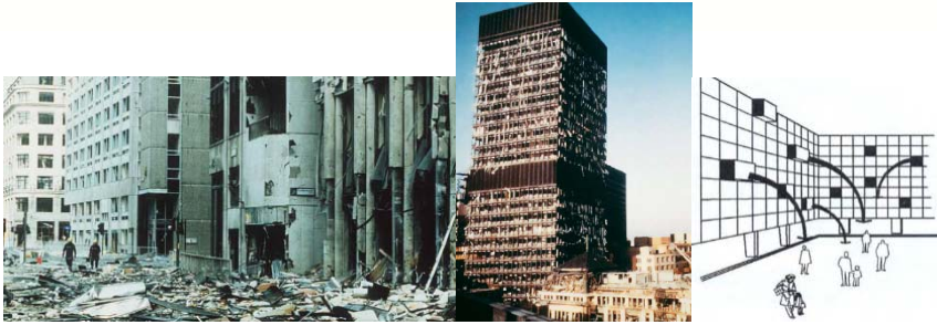
شکل ۲۴- پرتاب عناصر نما خسارت خیابانی را بیشتر می‌سازد (FEMA, 2006:200) (مرکز تحقیقات ساختمان و مسکن، ۱۳۸۸: ۲۸) (Bloomberg et al, 2009: 10)
